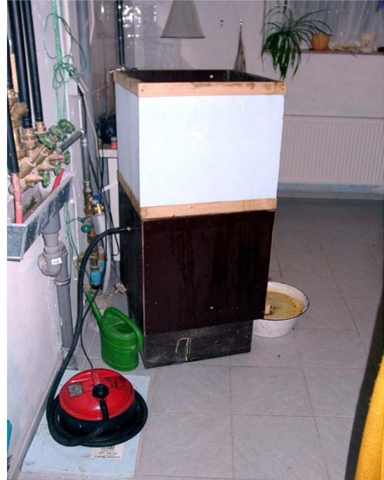
Bei Betrieb in sehr kalten Räumen ev. auch den unteren Schmelzbehälter einschließlich Boden von unten isolieren!
